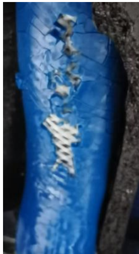
Figura 1: Manguito de drenaje degradado
